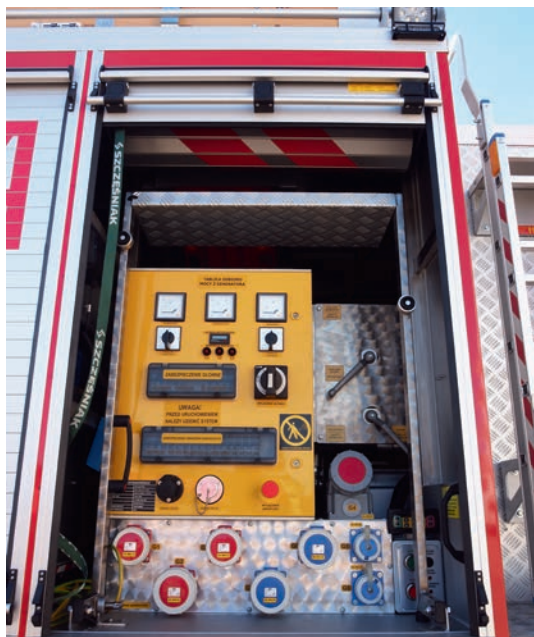
Fot. 11. W pierwszej skrytce nadwozia, za kabiną po prawej stronie umieszczona została tablica sterownicza generatora prądotwórczego LINZ ELECTRIC PRO 18S A4 – IP 23
